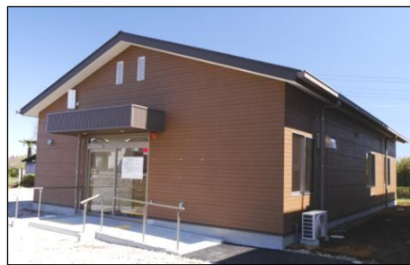
新築された建物
